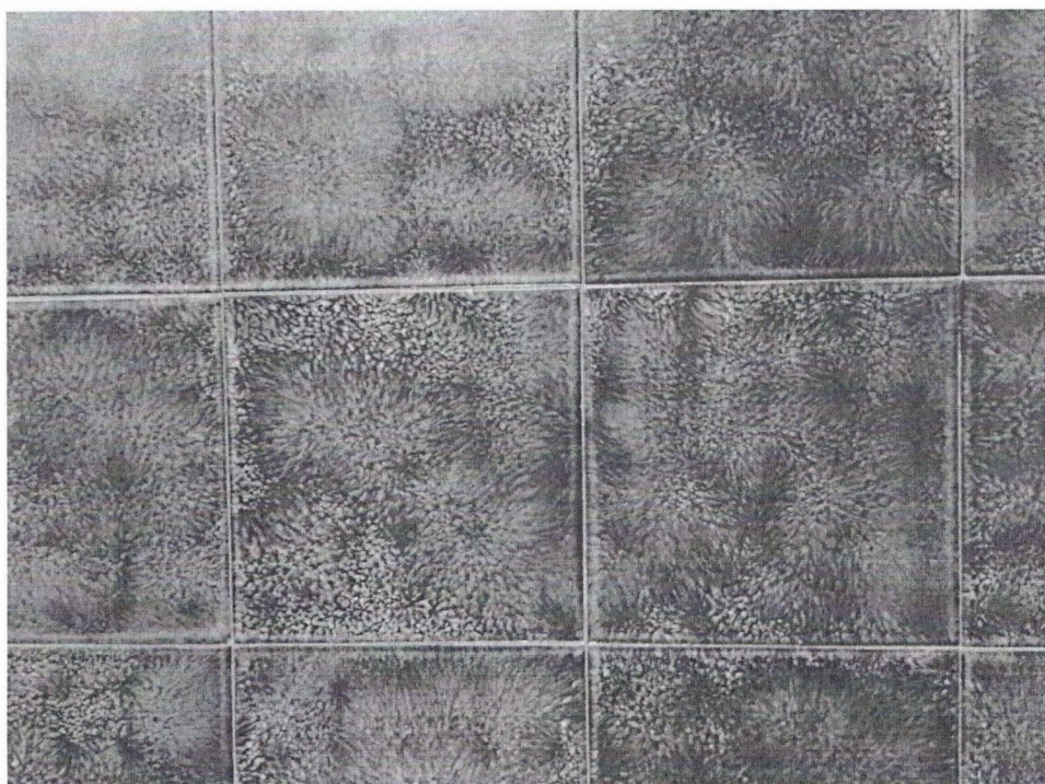
Foto n°15- particolare della pavimentazione
